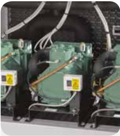
Compressore semiermetico completo di accessori. Semi-hermetic compressor with accessories.
